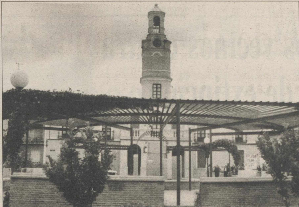
El incendio de Malagón se originó cerca del depósito de agua.
