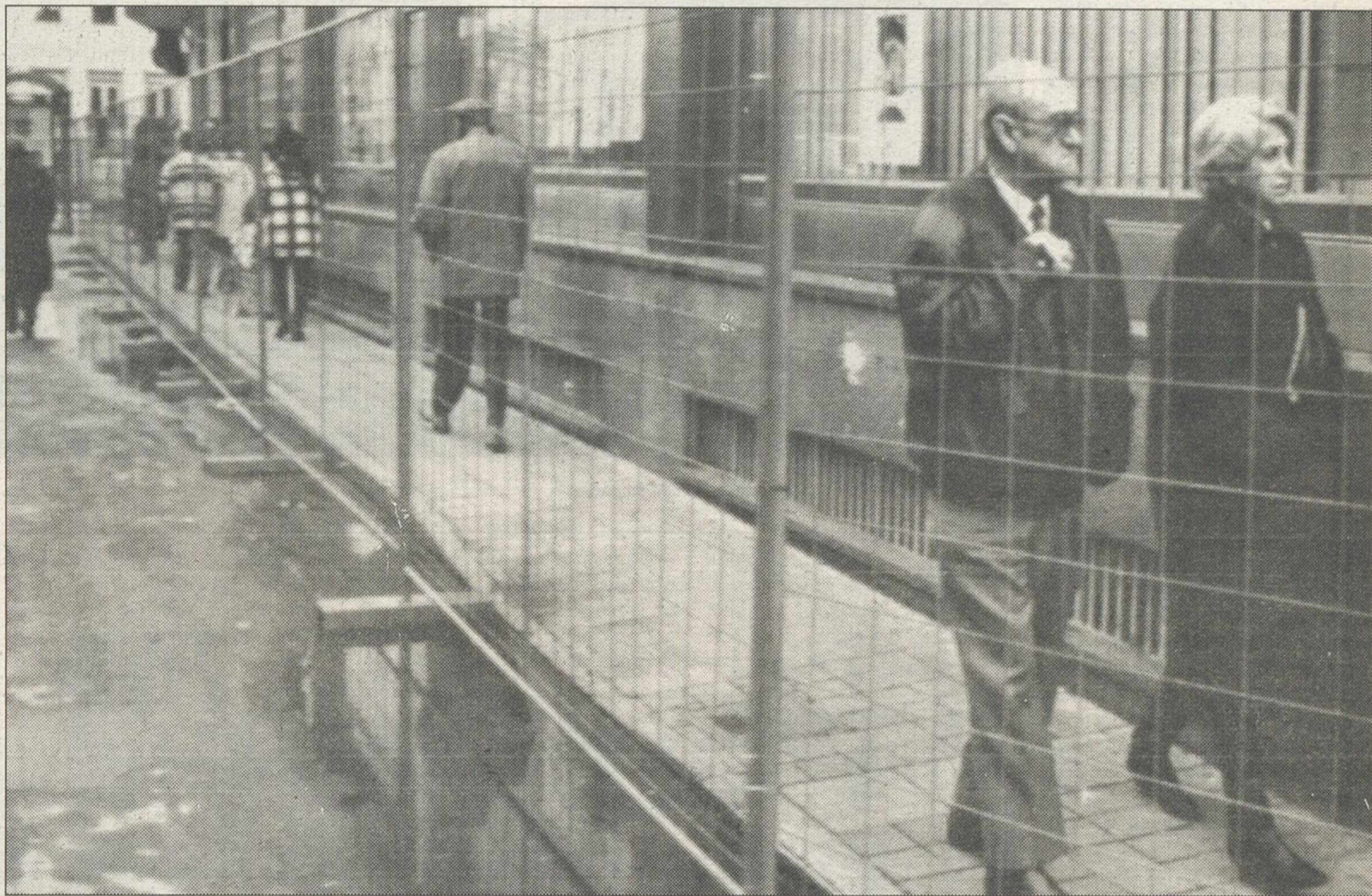
Las obras para la peatonalización de las calles ya han comenzado en Ciudad Real
