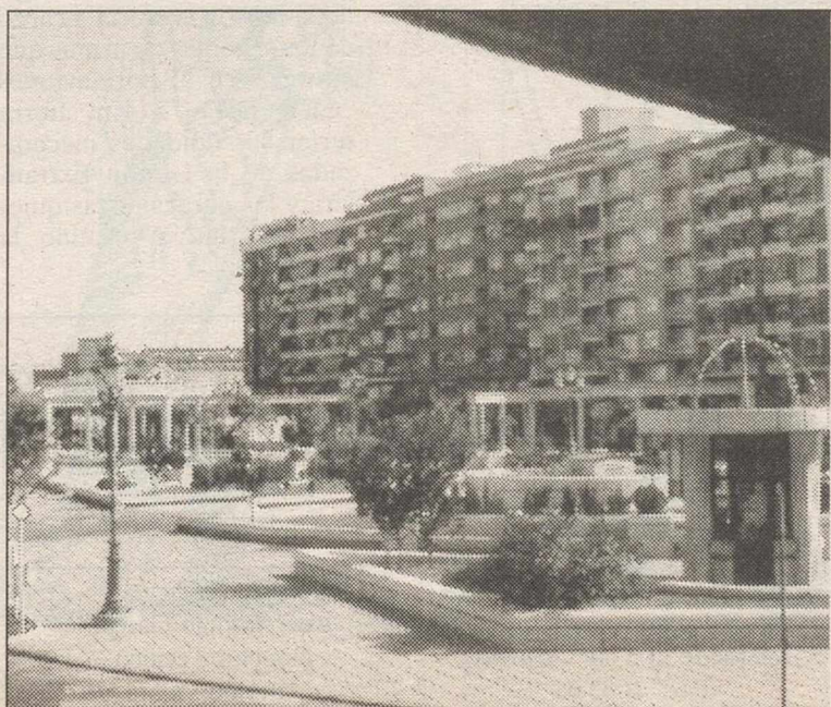
Las empresas de Puertollano ya han presentado un plan logístico para realizar la obra.
