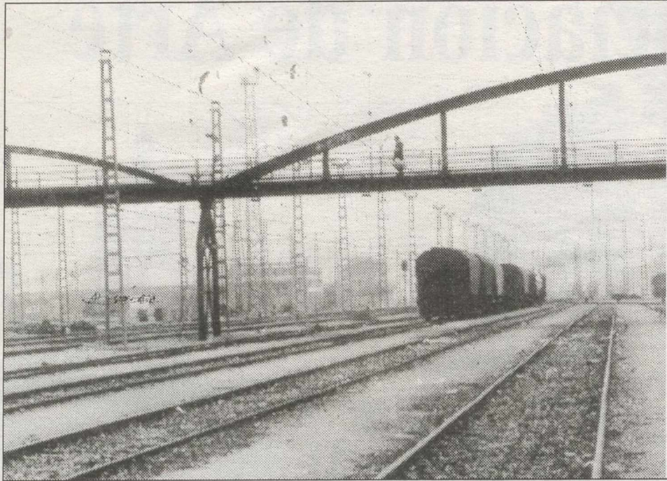
La cisterna fue aislada en la zona de clasificación de la Estación de Renfe.
