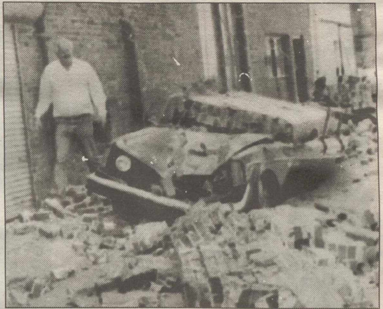
Los elevados daños materiales todavía no han sido cuantificados.
