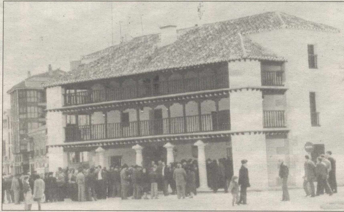
González-Valcárcel proyectó y dirigió la reconstrucción de la Posada de los Portales
