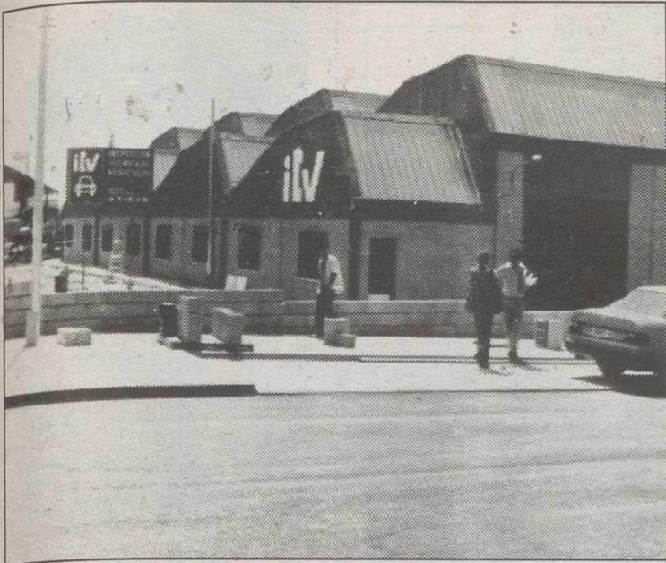
Instalaciones de la ITV en Puertollano.
