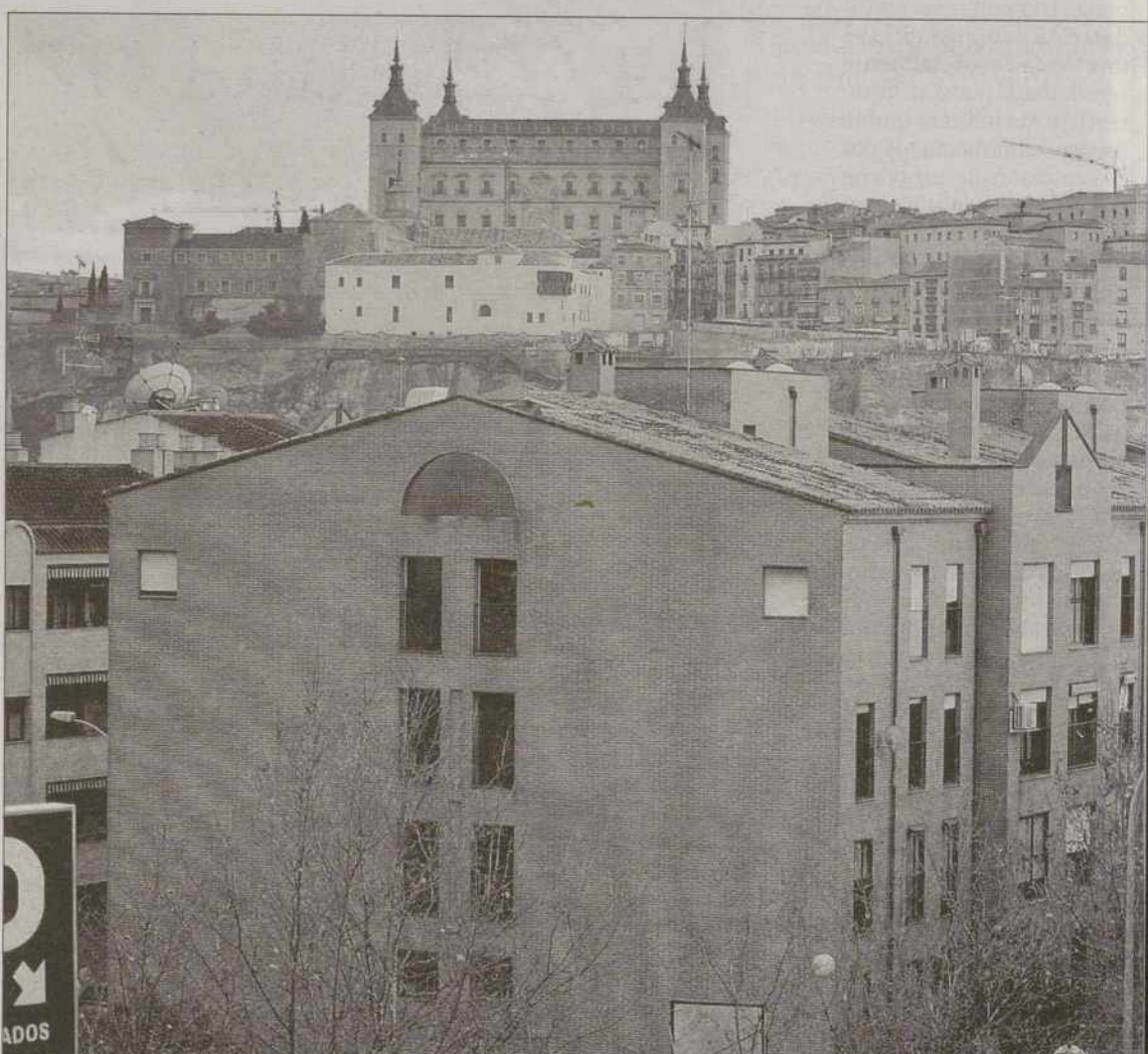
El edificio afectado, sito en Travesía Marqués de Mendigorría, está en pie desde hace 16 años. /DAVID PÉREZ
