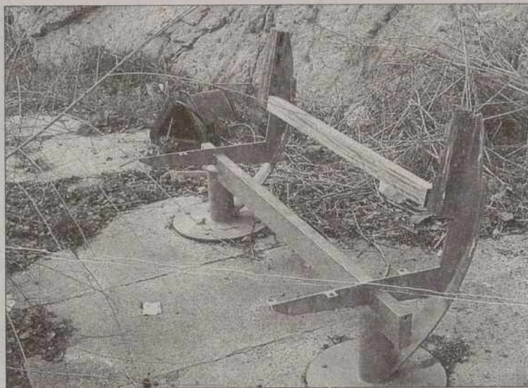
La situación de deterioro es visible en toda la senda. /L.T.
