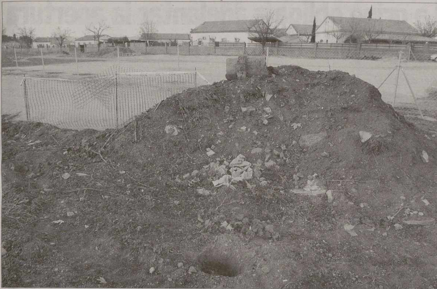
El edil de IU entiende que continúan todavía los trabajos. /YOLANDA LANCHÁ
