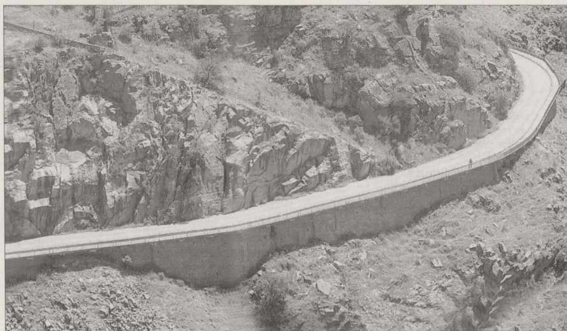
Vista de los metros objeto de estudio por parte de Geotecnia y Cimientos S.A. / YOLANDA LANCHA
