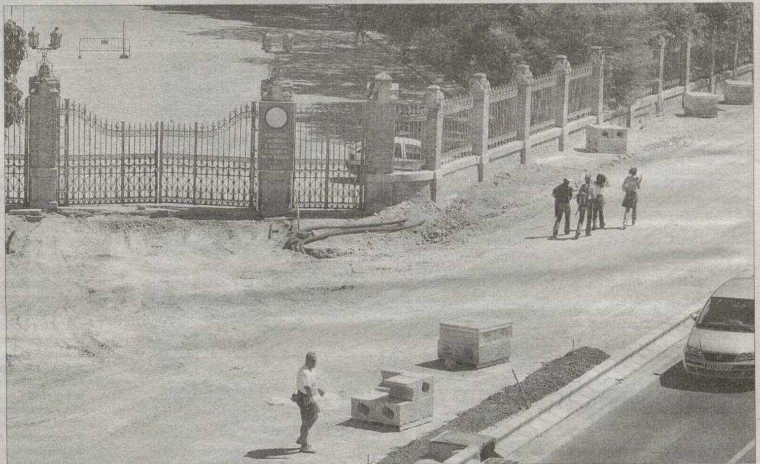
La valla de Renfe tiene que retroceder para que se ejecuten las obras del bulevar. /YOLANDA REDONDO
