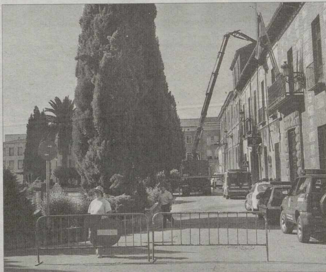
La grúa en la plaza del Pan evidenciaba ayer el comienzo de las obras en la comisaría de Policía Local. / MANU REINO
