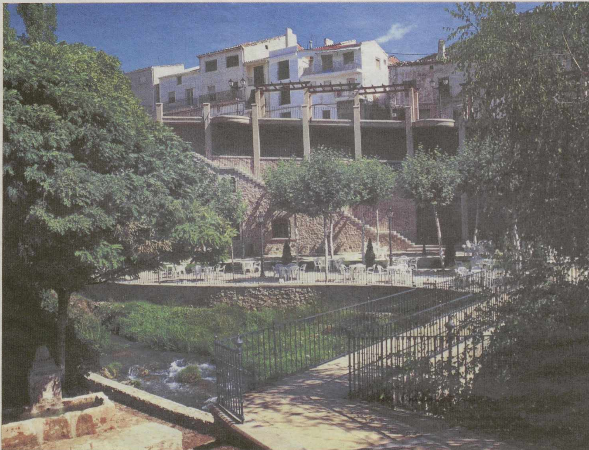
Centro neurálgico del pueblo convertido en zona de descanso por donde discurre el cauce del río Cifuentes que desemboca en el Tajo dentro de la localidad de Trillo. / PEPE ZAMORA
