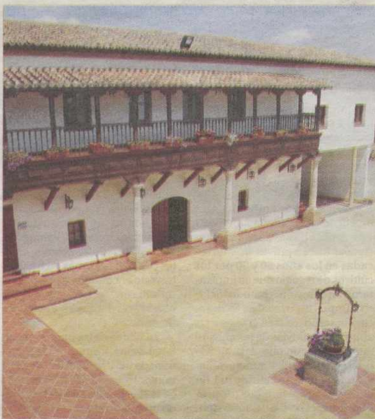
La edificación ha conservado las características arquitectónicas. / RUEDA
