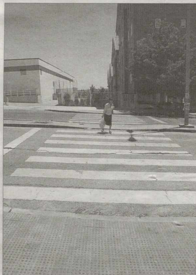
Los camiones aprovechan este paso de cebra para acceder al muelle marcha atrás.
