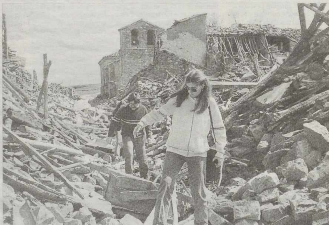
Así quedó el municipio de Alcorlo, días después de su derribo, en 1988. La iglesia fue trasladada a Azuqueca de Henares. /L.T.
