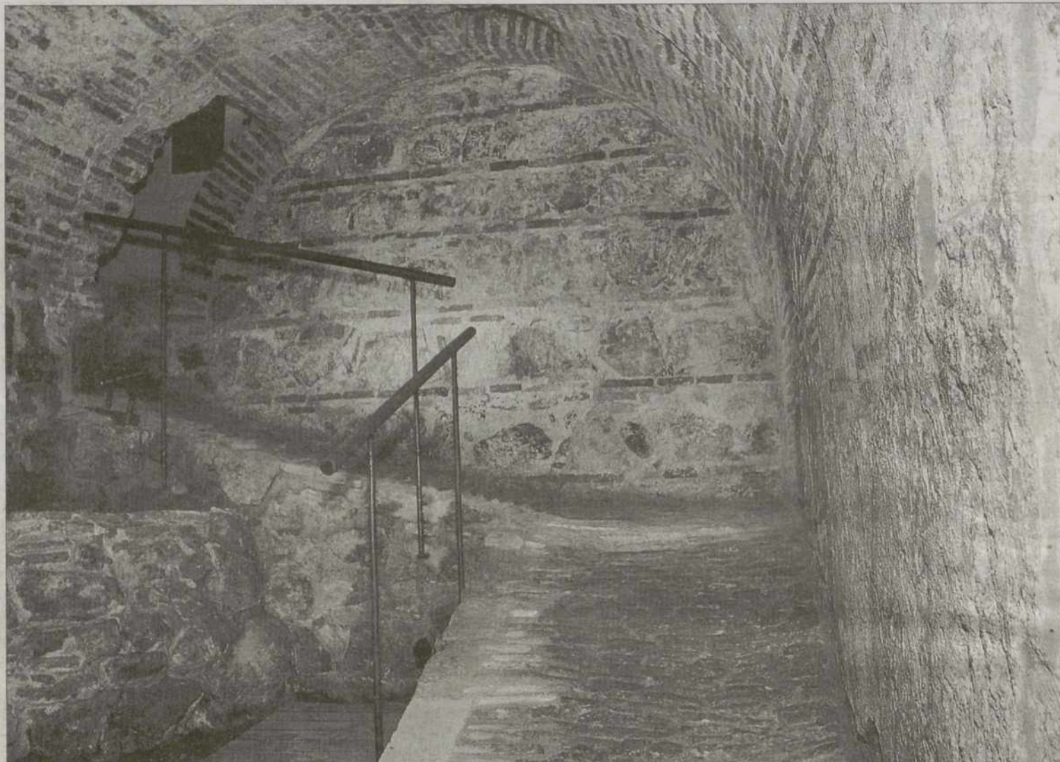
El acceso a los Baños del Cenizal (bajo de la calle Bajada del Colegio de Infantes, 14) aprovecha la rampa de ladrillo de cuando fue utilizado de caballeriza. / Y. REDONDO
