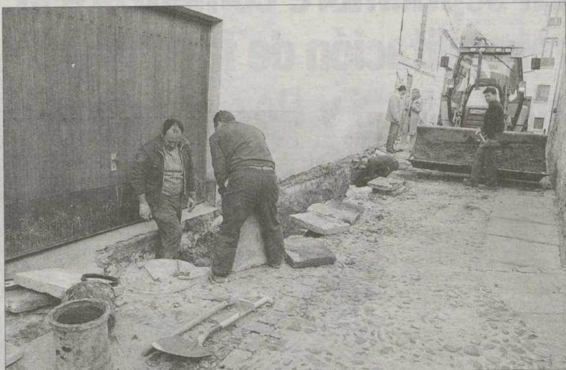
Cinco operarios sustituyeron la tubería reventada por otra nueva. / YOLANDA LANCHIA
