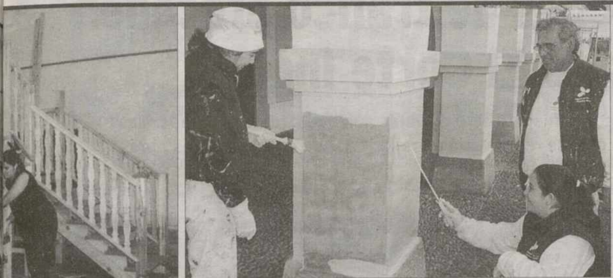
Trabajos de pintura. Además de la casa rural, los alumnos de la Casa de Oficios pintaron edificios en la Plaza de Regiones de Alcaudete. / L.T.
