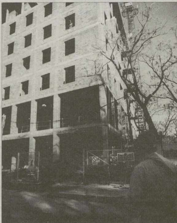
Un edificio en construcción en Sevilla.
