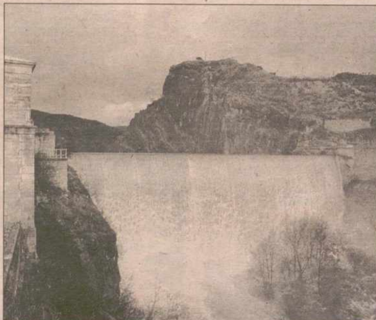
Presa de El Portón de la Oliva, del Canal de Isabel II
