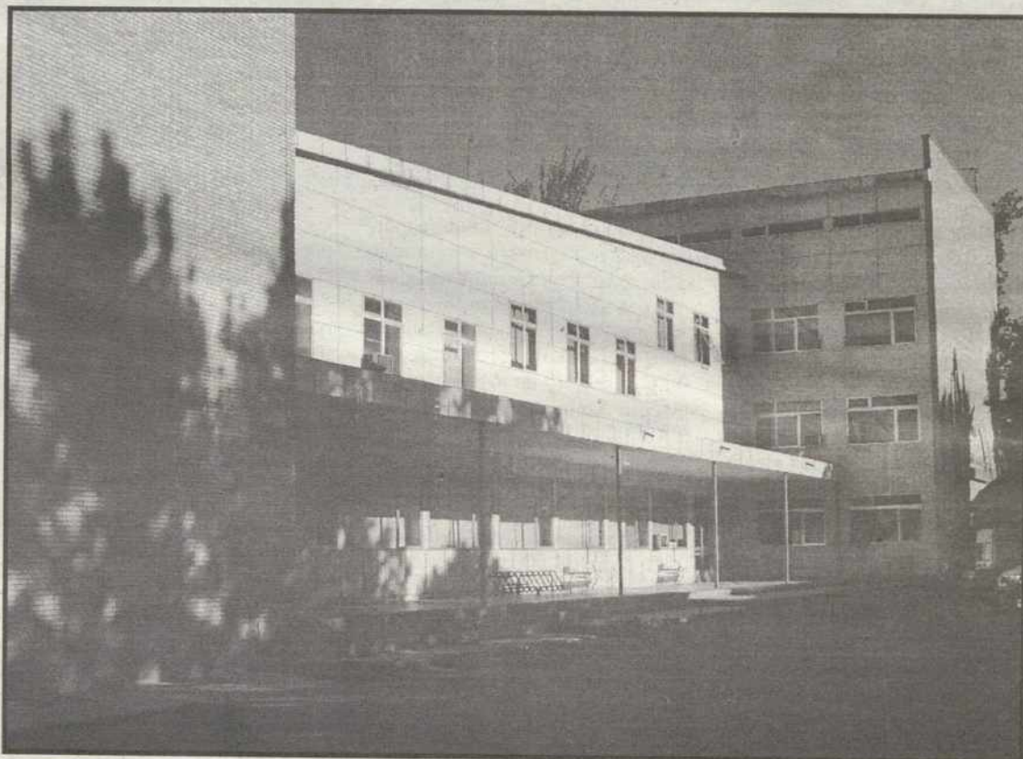
La fachada de la EUITA pasará a tener la misma imagen que el resto de edificios del campus Tomás Fernández
