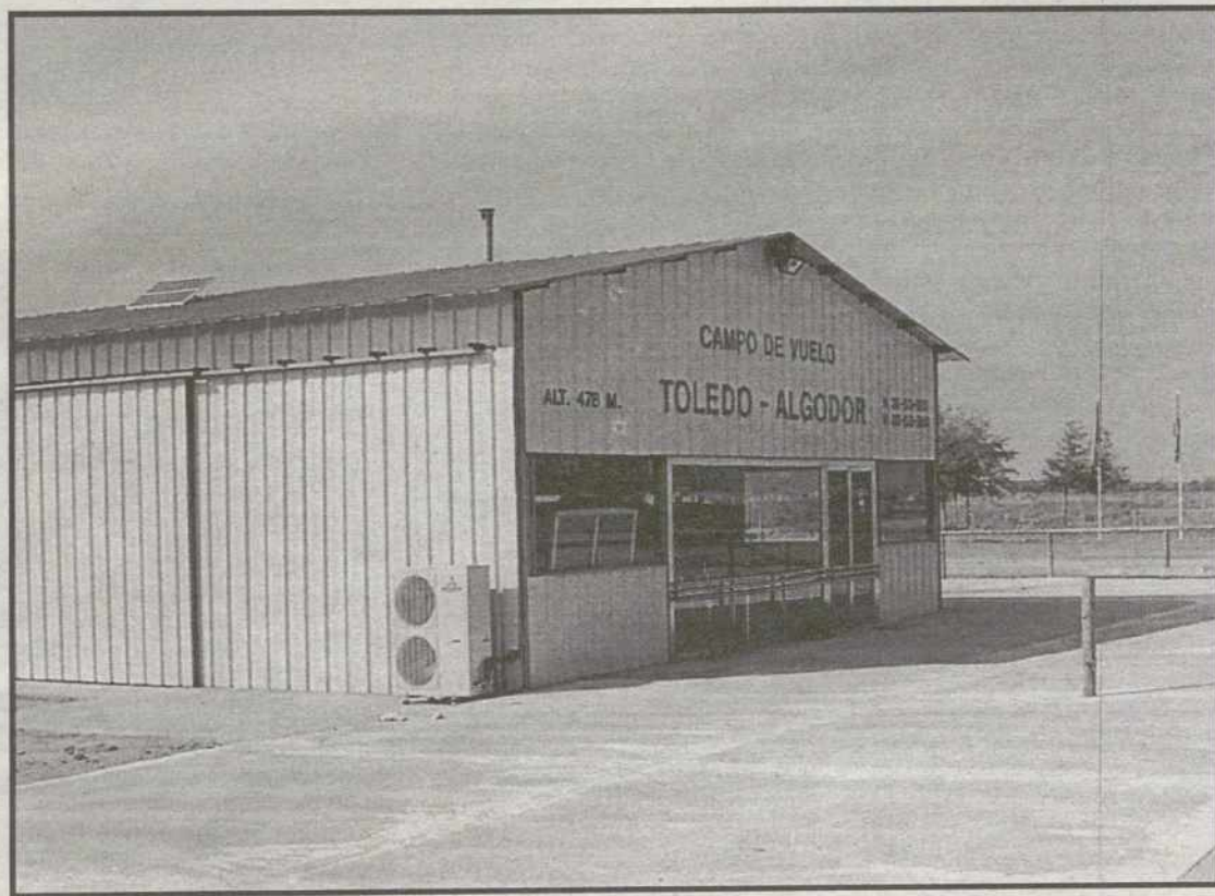
Parte de las instalaciones del aeródromo de Algodor
