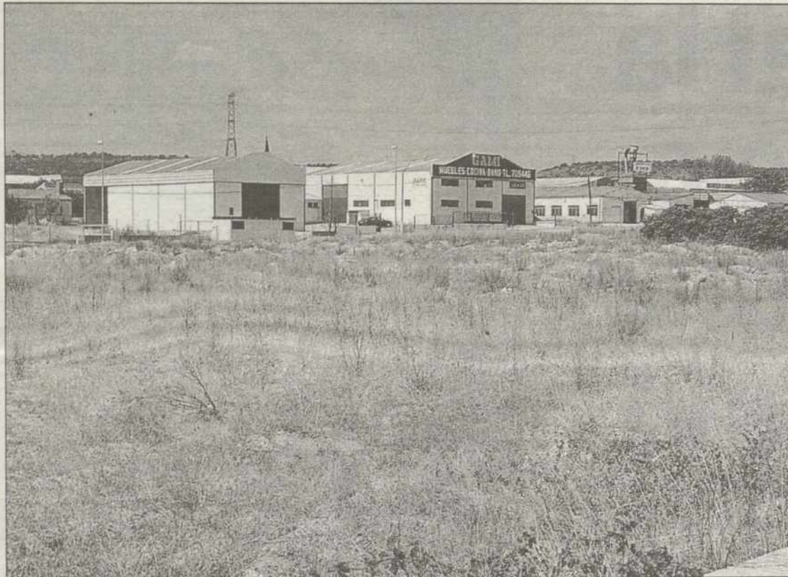
El futuro planetario se ubicará en unos terrenos del polígono Valdefuentes
