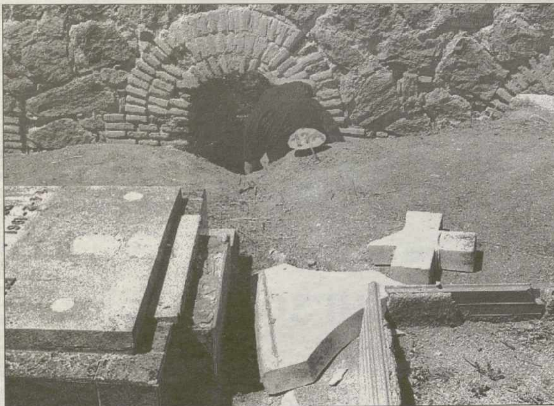
El hueco de un desagüe sin rejas, permite el paso al camposanto
