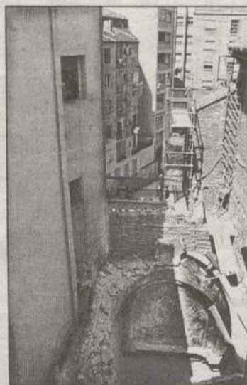
La bóveda derruida. EFE
