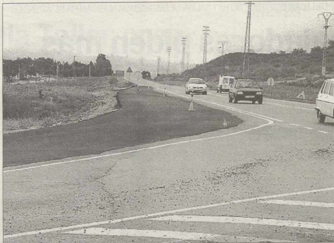
El barrio de Azucaica no atisba hasta la fecha el final de las obras en su carretera
