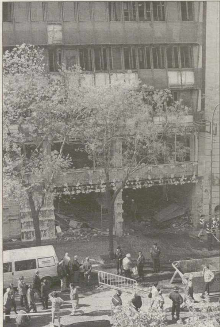
Estado de uno de los edificios afectados por la explosión
