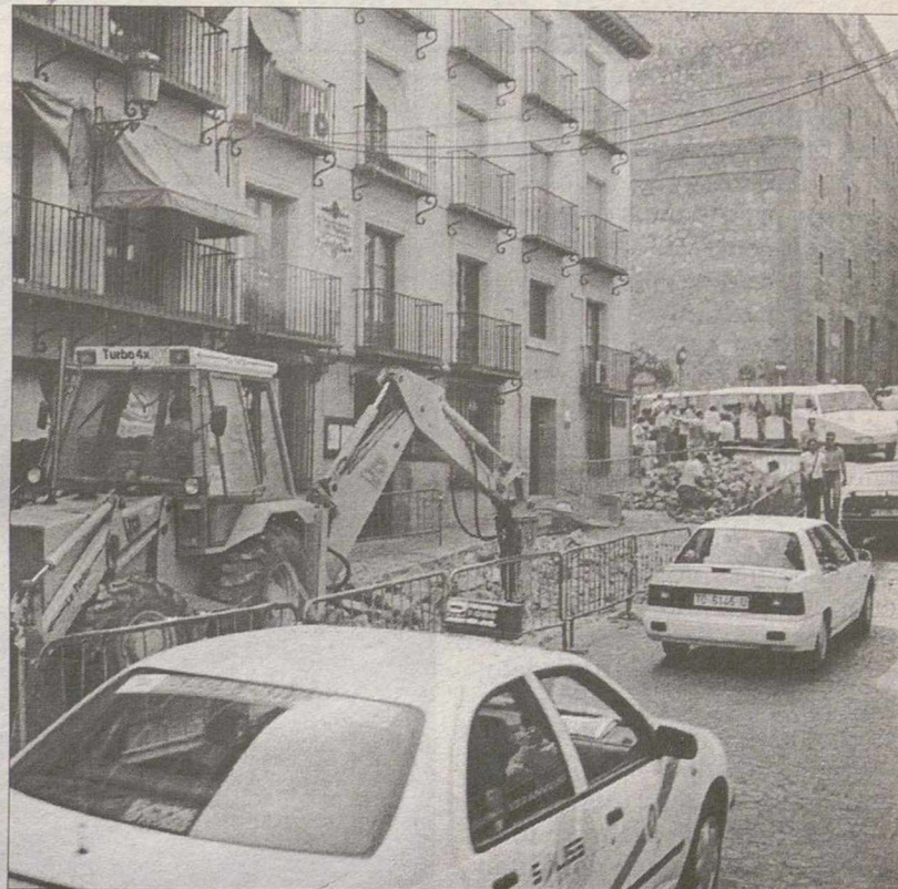
Conductores y peatones se verán afectados por las obras.
