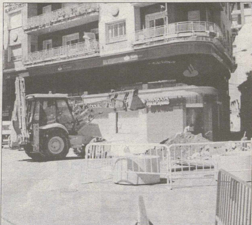
San Francisco y Ramón y Cajal son dos de las calles en obras.
