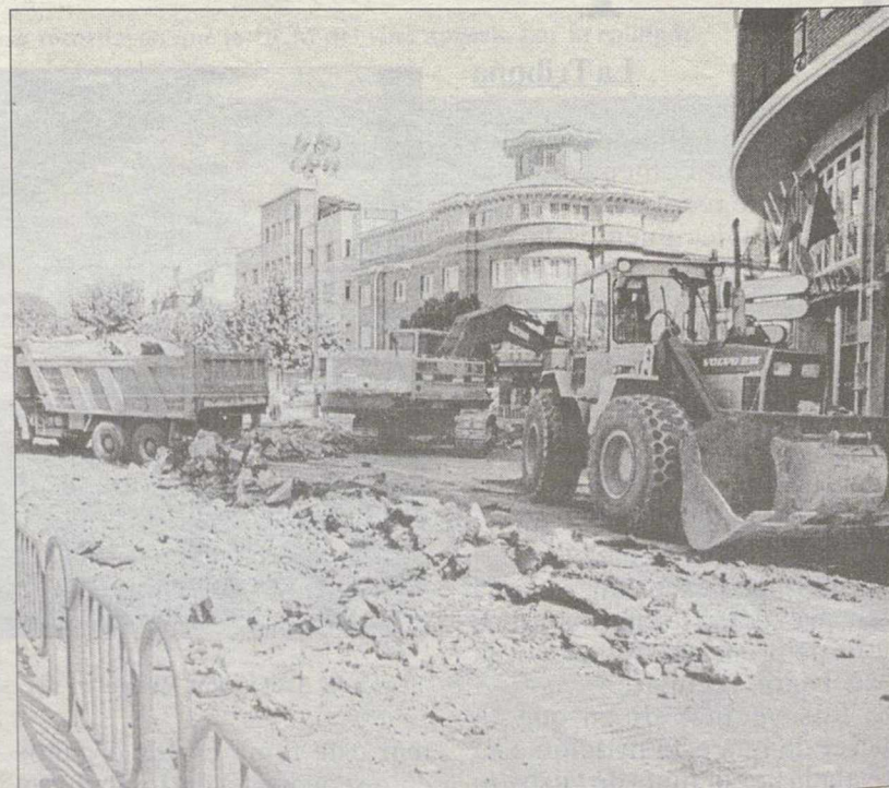
Las obras del centro han hecho cambiar el tráfico de la zona.
