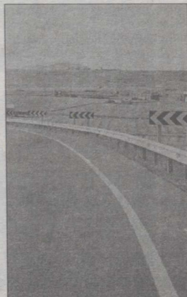
Las obras han mejorado el firme.
