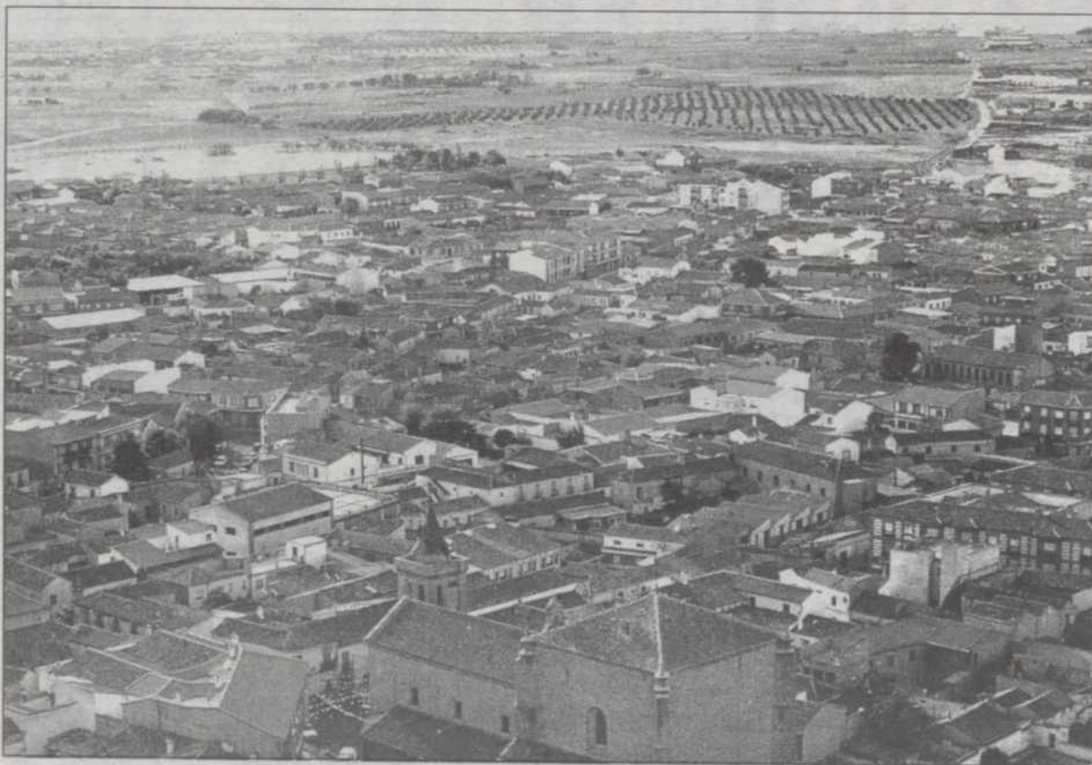
Uno de los proyectos del Ayuntamiento para el próximo año es la reforma del alumbrado de Sonseca.
