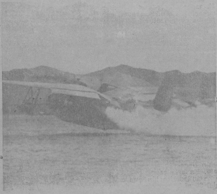
Dejando estelas de humo de escape, los motores de propulsión por reacción que van debajo de las alas de este hidroavión norteamericano, contribuyeron a elevarlo, durante pruebas efectuadas en el Pacífico
