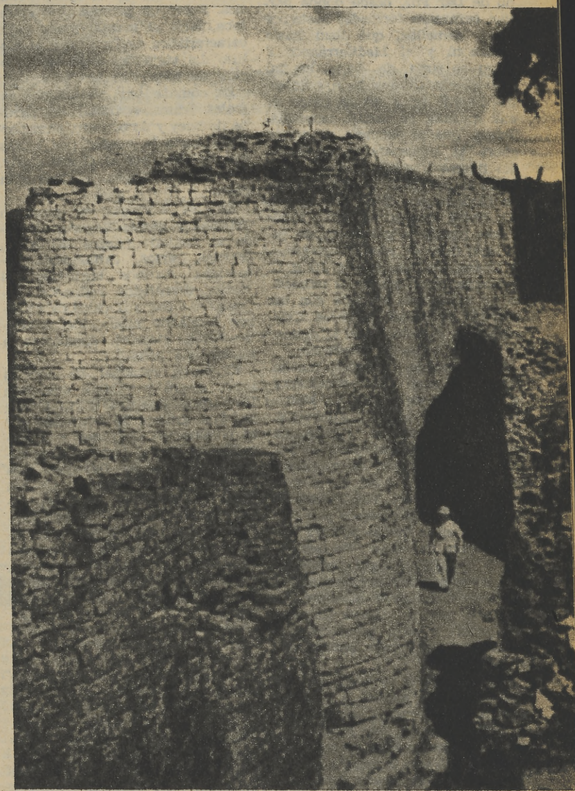
Las grandiosas murallas de la antigua ciudad real de Zimbabué, situada en plena selva de Rhodesia, que se construyeron sin argamasa
