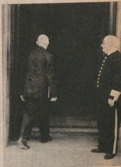
La puerta de la calle de Floridablanca, por donde entran los Procuradores a la Sala de Comisiones de las Cortes
