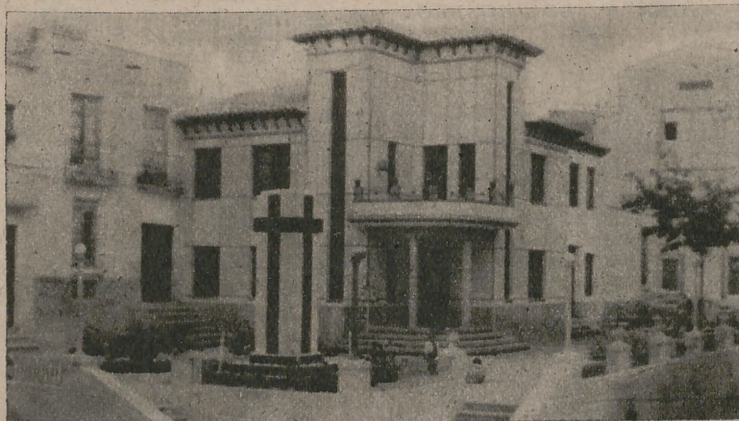
La casa parroquial, de moderna construcción, y el Monumento a los Caídos
