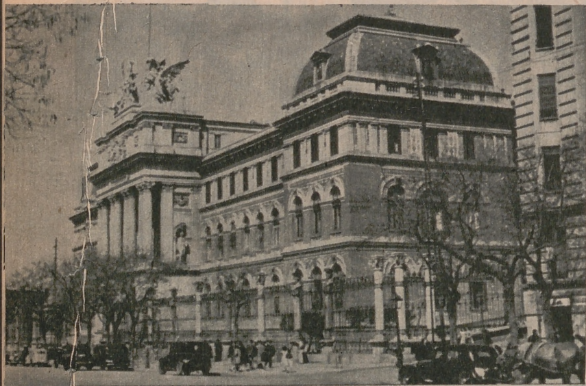
El edificio del Ministerio de Fomento, en Madrid, que ha albergado, a lo largo de su historia, a varios Departamentos ministeriales
