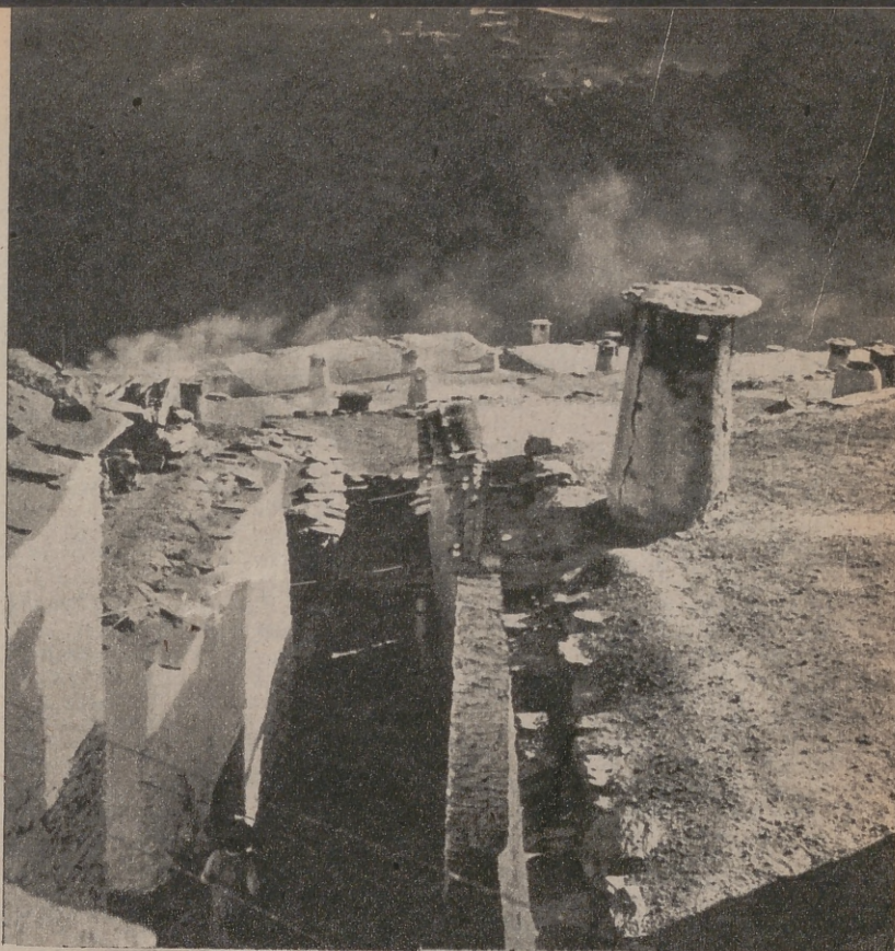
Chimeneas y terrados de tierra impermeable, bajo los negros nubarrones de una tormenta a 1.450 metros de altitud
