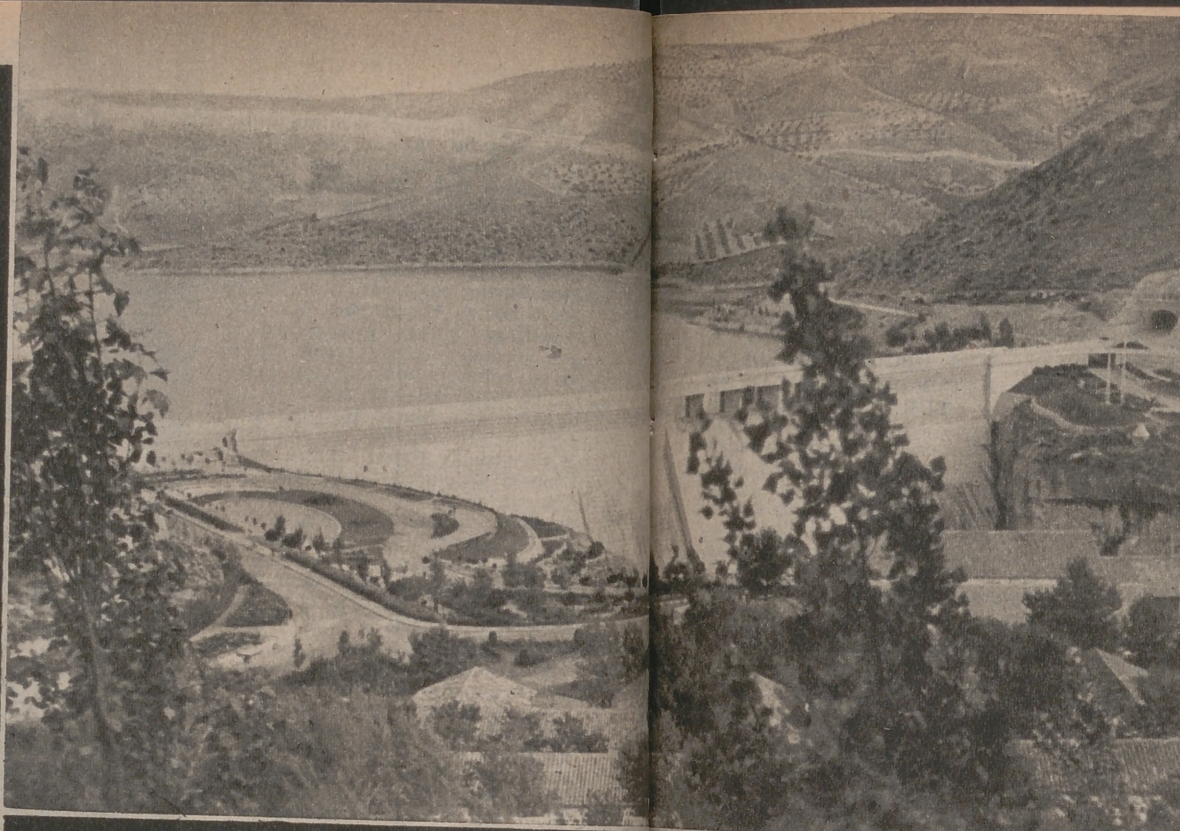
Una vista de la presa y el comienzo del embalse, que inmensamente se extiende a la izquierda para extenderse en 55 kilómetros. Tiene capacidad para noventa millones de metros cúbicos
