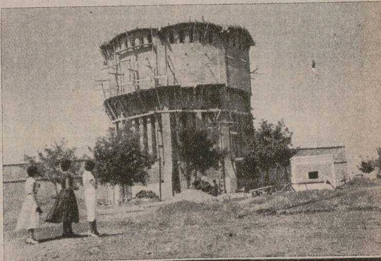
Depósito elevado en construcción para el abastecimiento de agua potable a la ciudad
