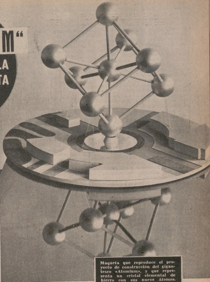
Maqueta que reproduce el proyecto de construcción del gigantesco «Atomium», y que representa un cristal elemental de hierro con sus nueve átomos. Tendrá de altura 140 metros, y en la esfera superior funcionará un restaurante
