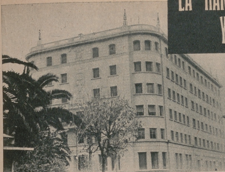
Nuevo edificio de la C. N. S., en Castellón
