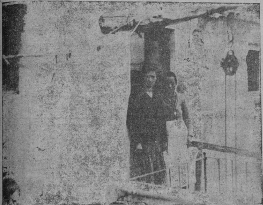
Las dos vecinas que fueron las primeras personas que se dieron cuenta del suceso, fotografiadas en el mismo portal de la casa que habitaban los asfixiados
