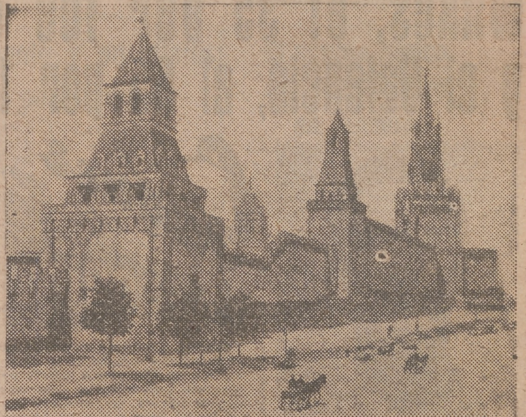
VISTA PARCIAL DE LA MURALLA DEL KREMLIN
