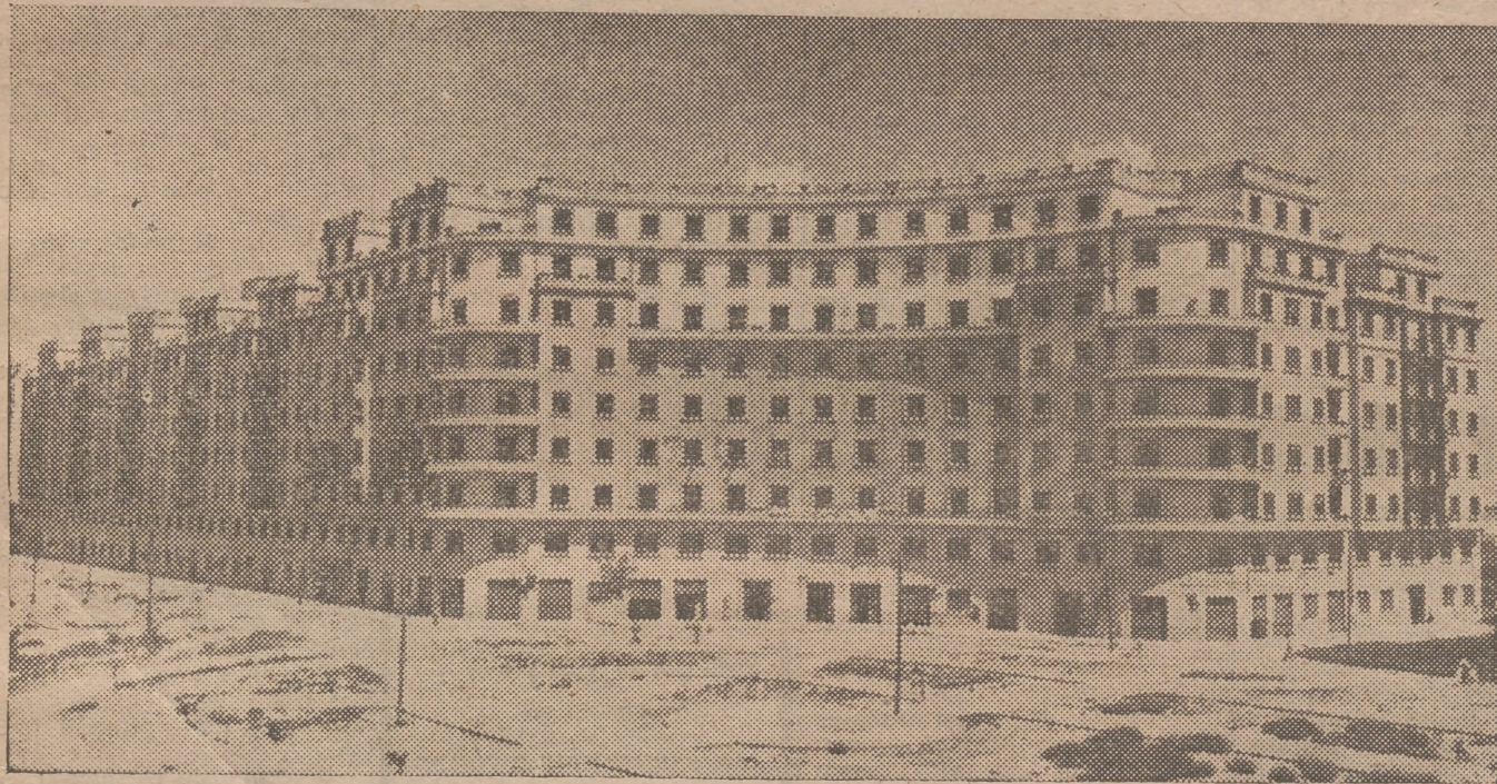
Vista parcial del magnífico GRUPO DE VIVIENDAS edificado por C. O. L. E. S. A. en el modernísimo Barrio de San José
