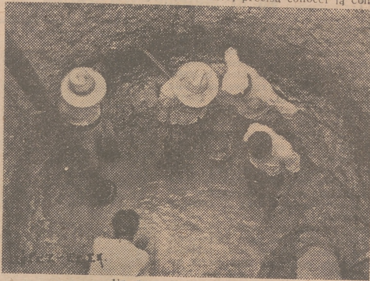
Un pozo en construcción
