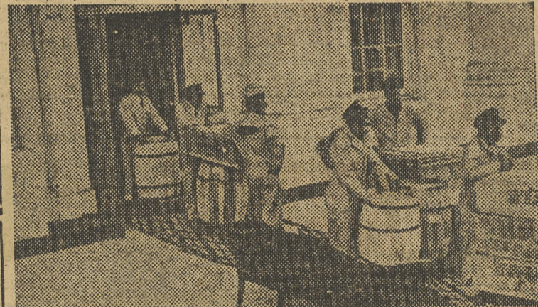
Los restos de la Casa Blanca, caídos bajo la piqueta de los demolidores, son expedidos en cajas y toneles a Fort Myer, donde serán cuidadosamente clasificados y empaquetados antes de ser puestos a la venta
