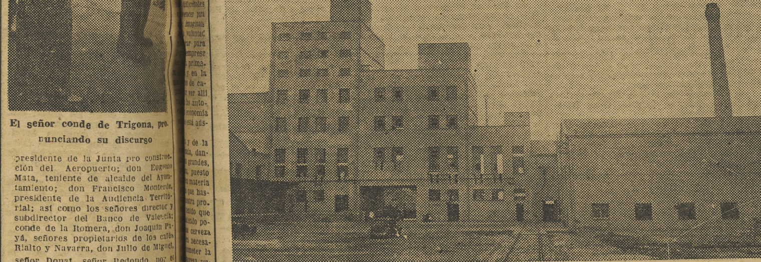
La fábrica, vista desde la carretera real de Madrid
