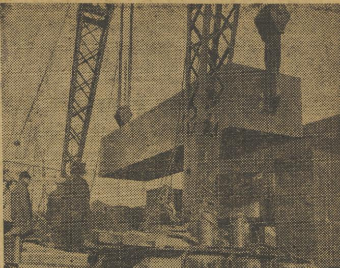
Rochester (Nueva York). — El último de los inmensos bloques de acero que componen el superciclotrón actualmente en construcción en los terrenos de la Universidad de Rochester es colocado en su sitio mediante una grúa imantada. Entre la línea de ferrocarril y el lugar de emplazamiento del ciclotrón, una distancia de 473 pies, ha sido tendida una vía especial. — (Foto Cifra Gráfica)
