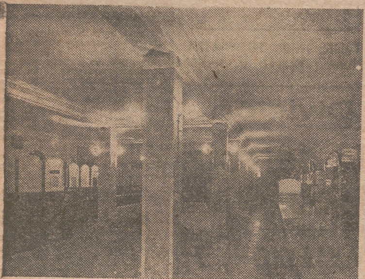
VISTA DE CONJUNTO DE LA NAVE CENTRAL
